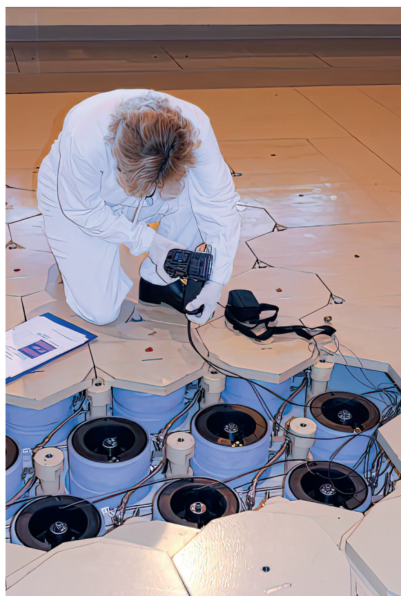
Tárolócsövek plombálása a KKÁT-ban
