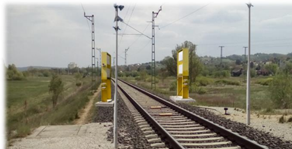
Vasúti pálya mellé helyezett sugárkapu.
