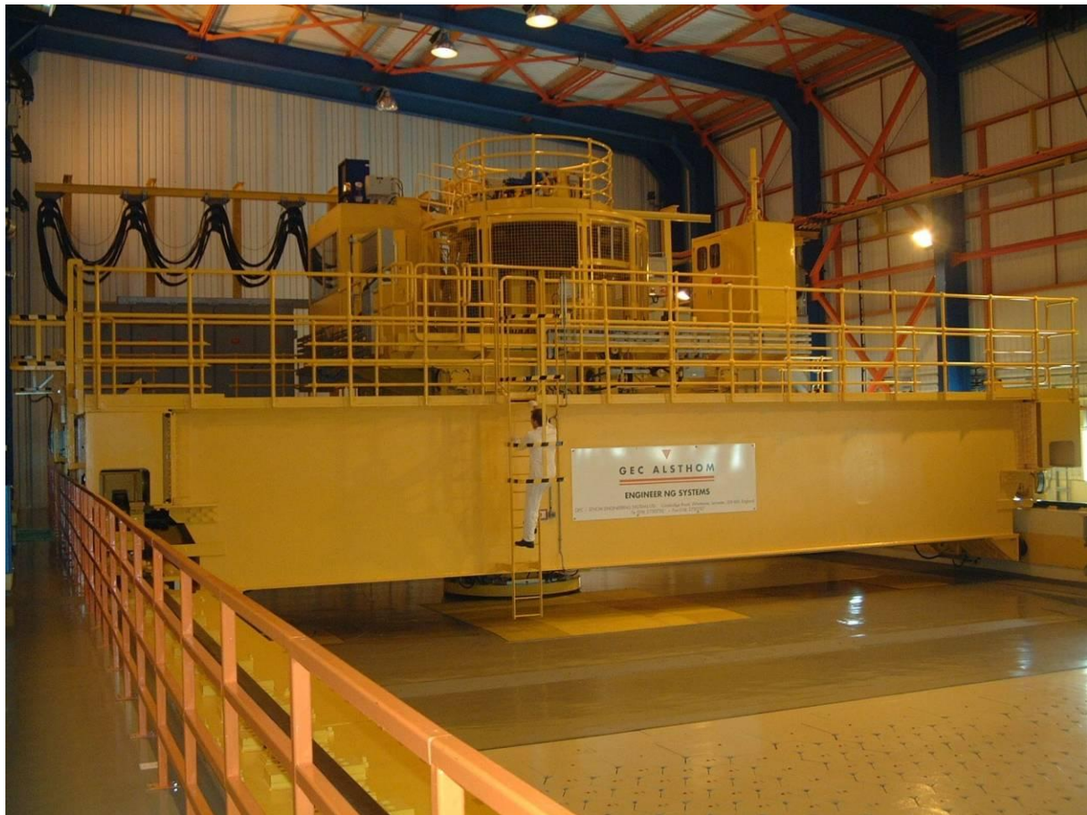
G.1 – 2. ábra Kiegészített Kazetták Átmeneti Tárolója: átrakógép
